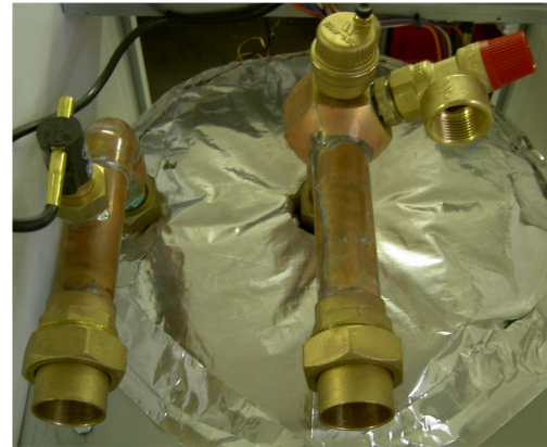
Inlaat/uitlaat soldeer aansluiting dia. 42 mm
